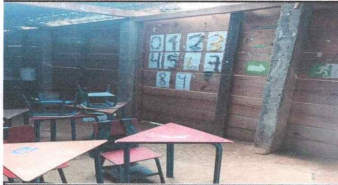
**Foto 1:** Imagen del aula No. 1 en donde se evidencia la necesidad de habilitación de pared de block, ya que se cuenta con columnas y bases de concreto.
