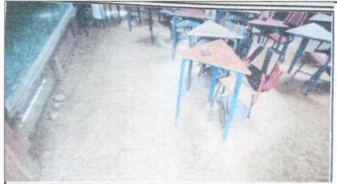
**Foto 2:** Imagen de aula donde se nota la necesidad de sustitución del piso de concreto, ya que el actual se encuentra en mal estado.
