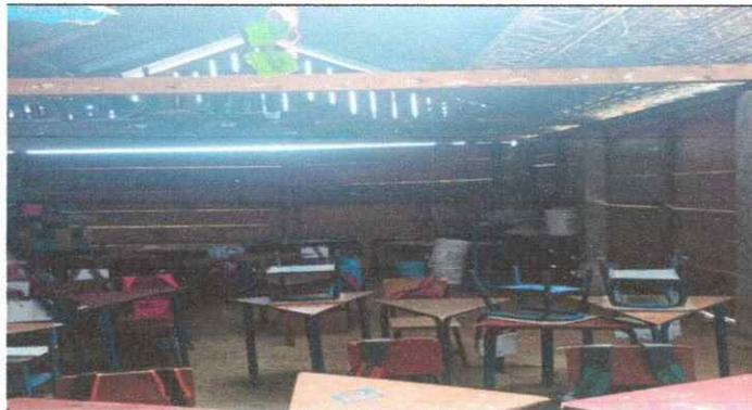
**Foto 3:** Vista interna de estructura de soporte de madera que necesita ser cambiada por metal, debido a que la actual estructura se encuentra muy deteriorada.
