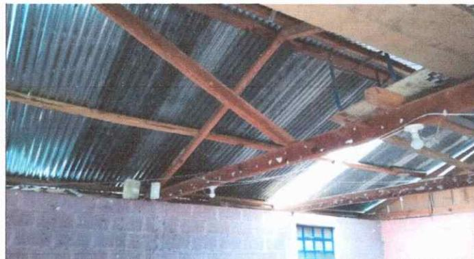
**Foto 4:** Otra vista de laminas actuales en aulas del establecimiento la cual reflejan la necesidad de cambio ya que se encuentran en mal estado.
